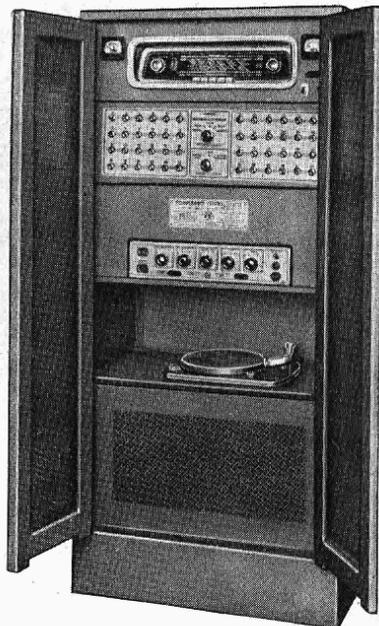
**Sintonizzatore:** per M.d.A. e M.d.F. mod. G 535 - 4 gamme d'onda - 5 valvole più 1 indicatore di sintonia e 1 raddrizzatore.
