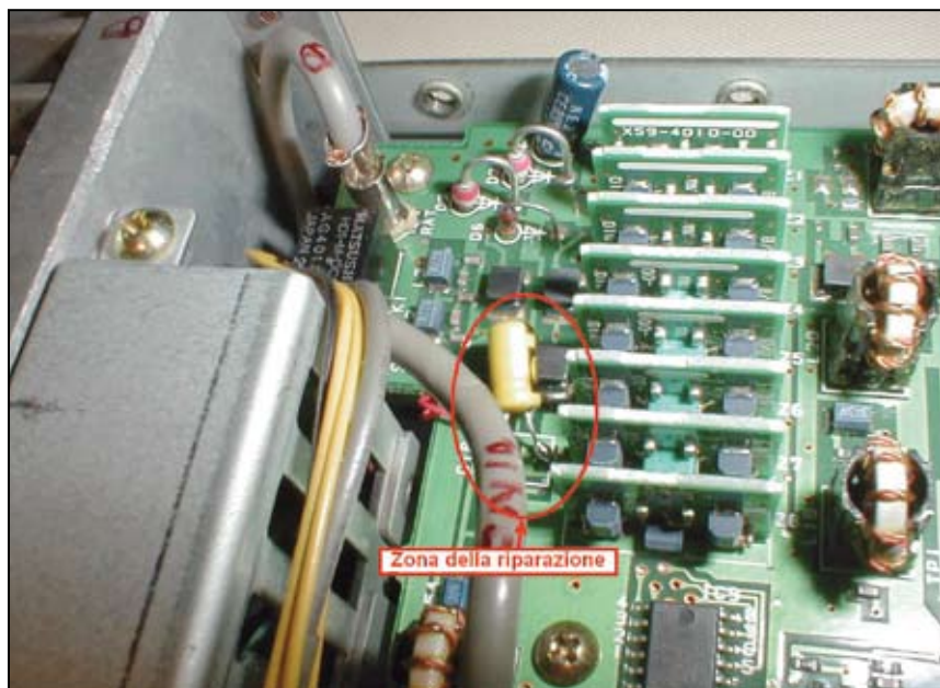
Foto 4 - La zona di intervento
