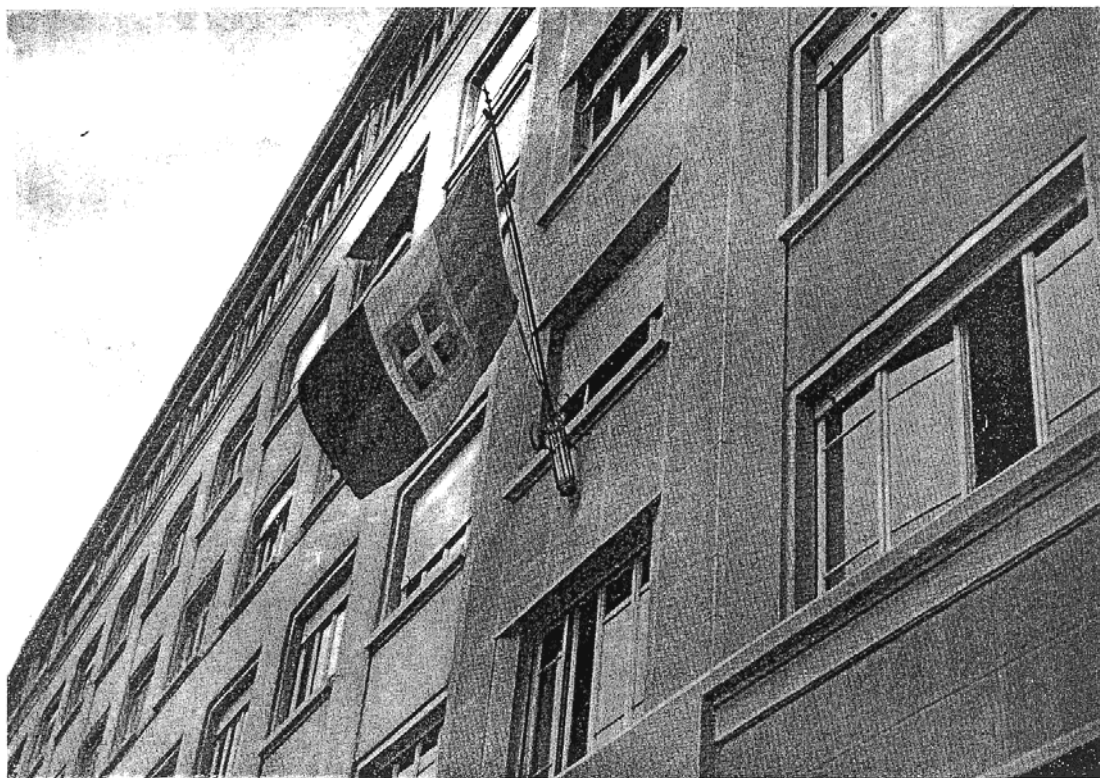
Scorcio di una parte della facciata (Lato est).
